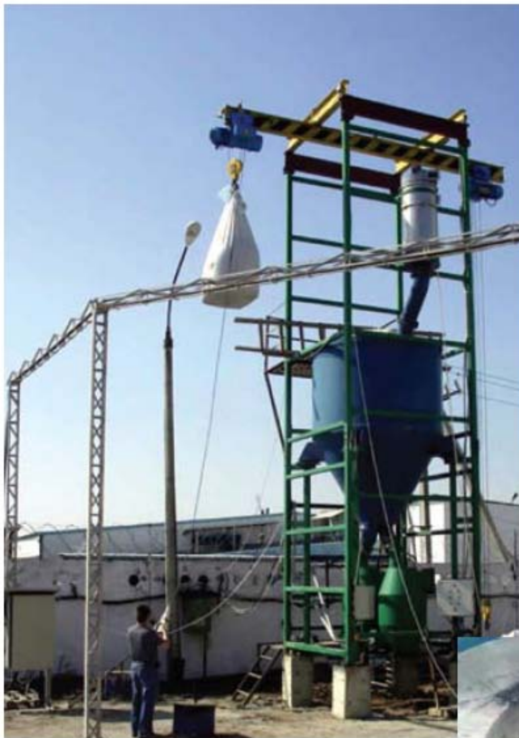
Рис. 3. Подача биг-бэга тельфером в зону растаривания
